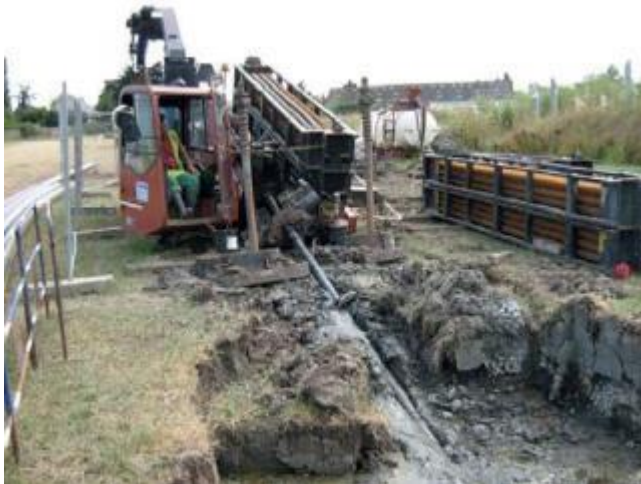
Illustration 10 : Chantier forage dirigé
