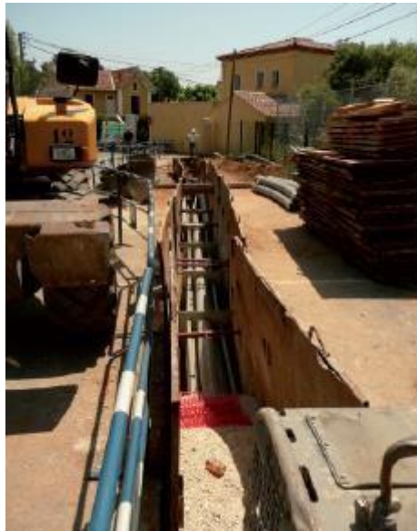
Illustration 8 : Mise en place de fourreaux PVC
