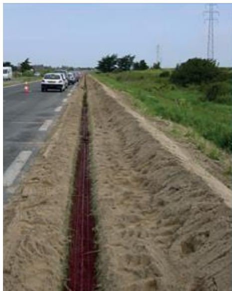
Illustration 7 : Tranchée avec fourreaux en PEHD
