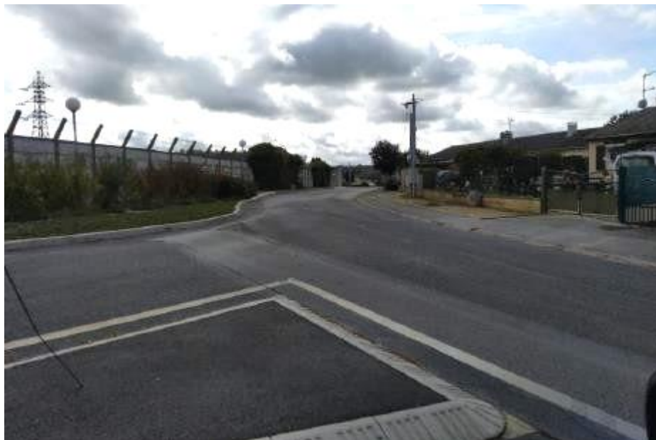
Illustration 4 : Départs depuis le poste RTE
